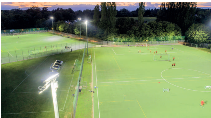
Das «Stade des Trois-Chêne» in Chêne-Bourg (GE). Die alte Beleuchtung wurde durch asymmetrische LED-Leuchten saniert. (Bild: Gian Vaitl)
